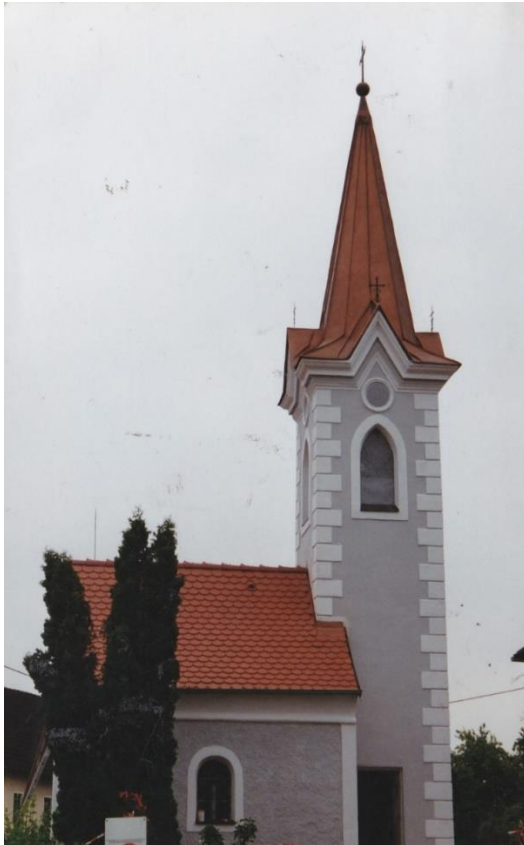
Die Kapelle nach der Renovierung 1995
